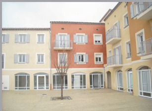
Agence Drôme Provençale « Vignes 1 et 2 » à Vinsobres
