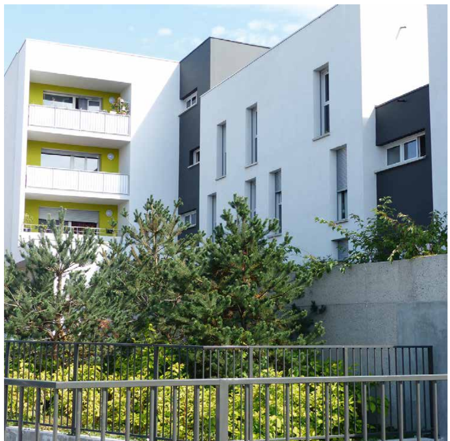
BOURG-DE-PÉAGE - Résidence Lucie Aubrac - 28 logements Réalisation en Label Effinergie - Bâtiment Basse Consommation (BBC) Architecte : M. COGNE
