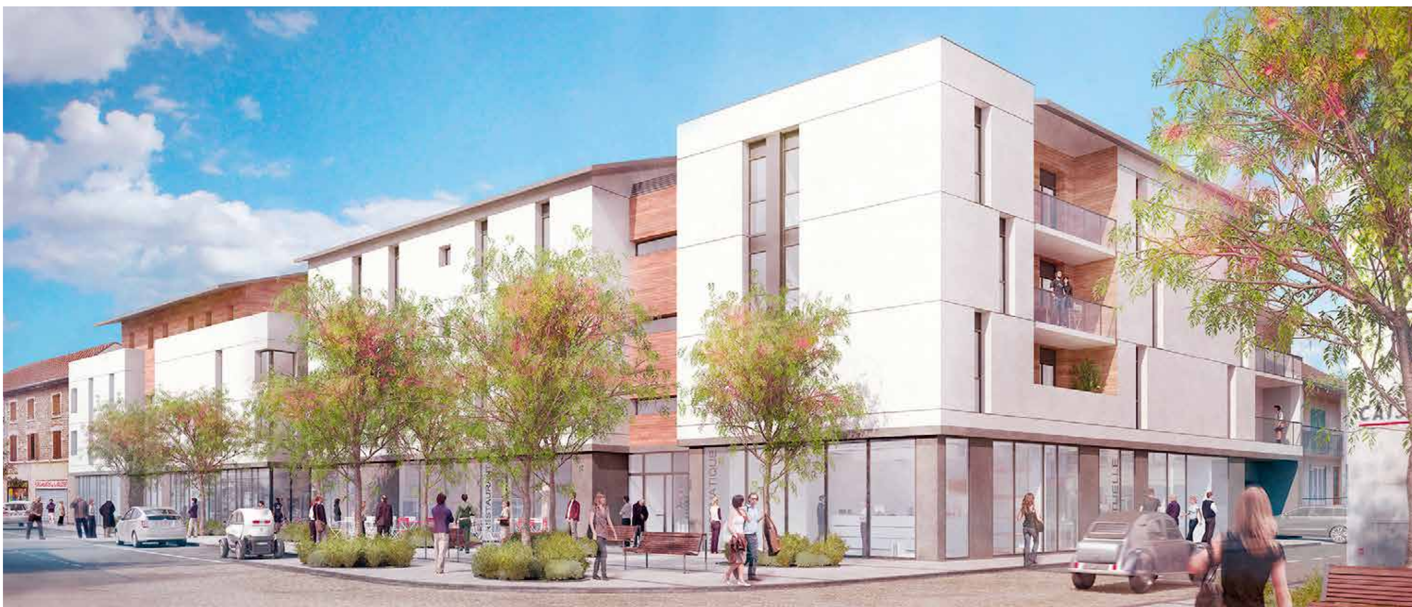
ANNEYRON - Place Rambaud - 20 logements et locaux commerciaux Opération dédiée aux seniors intégrant un système de « veille bienveillante » Réalisation en label Effinergie + et QEB BBC+ du référentiel Région Auvergne-Rhône-Alpes Architectes : Atelier Paris & Associés
