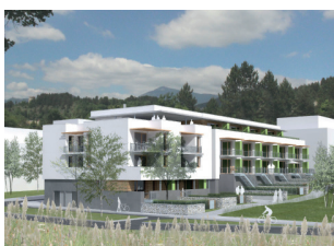
Agence Val de Drôme Résidence Chanqueyras îlot F - Die
